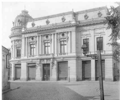
Prima clădire a Fundației, inaugurată în 1895
